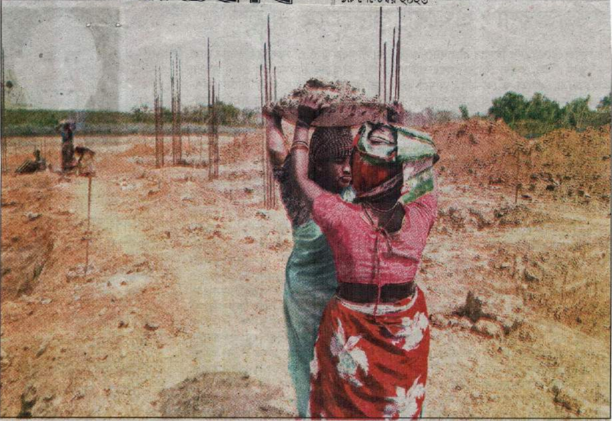
কমলগঞ্জ (মৌলভীবাজার) : শমশেরনগর এলাকায় একটি ভবন নির্মাণের কাজ করছে চা-বাগানের নারী শ্রমিকরা
